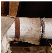
isolamento de tubagem
